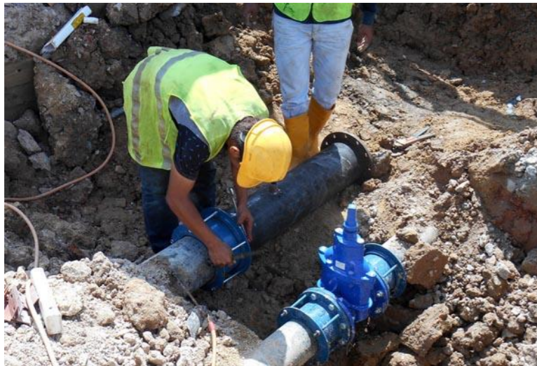
Réalisation du Réseau d'eau potable
