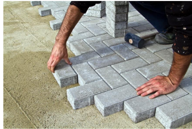
Revêtement des places et voies piétonnes en pavé autobloquant
