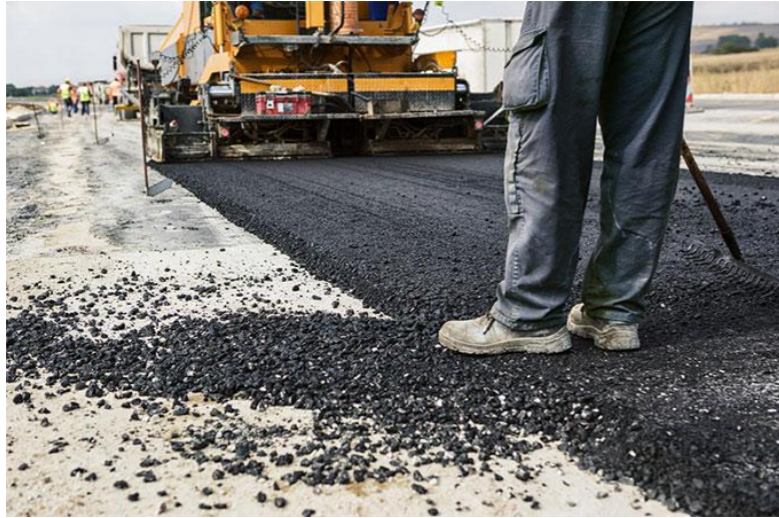
Goudronner les voies carrossables
